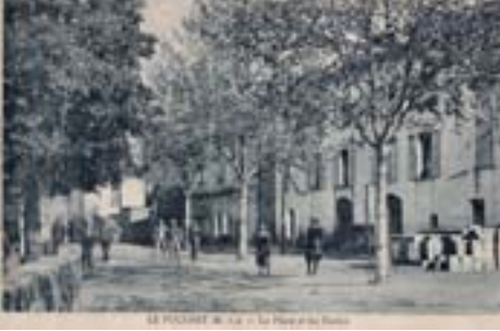
Le Fugeret, école
