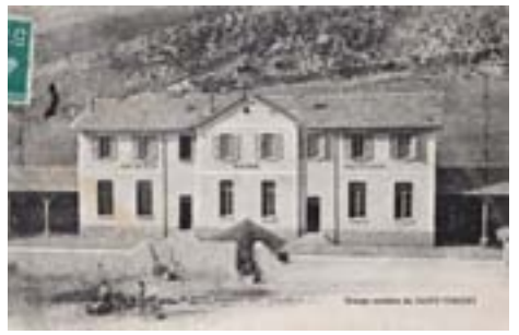
Saint-Vincent-sur-Jabron, groupe scolaire
