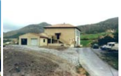
Bevens, même école en 1994 après des travaux d'aménagement, 2013
