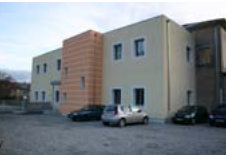
Saint-André-les-Alpes, l'école, façade nord, 2013
