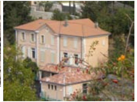
Claret, école rénovée en 2009, 2013
