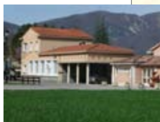
Bâtiment d'école de Marcoux devenu mairie
