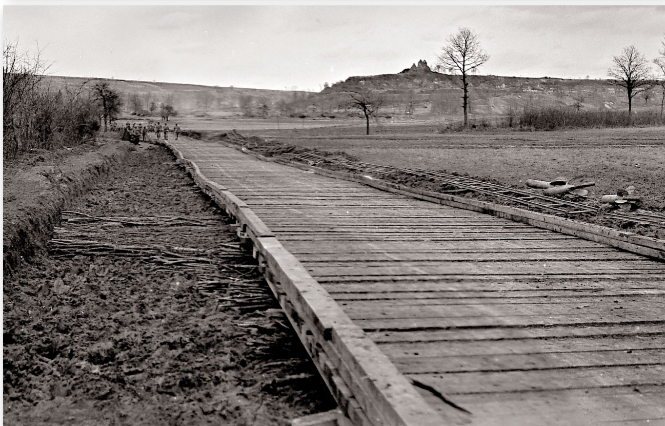
61 Fi 3590 et 3591, Chemin des Dames , la piste en madriers que j'ai construite de nuit pour l'attaque du Chemin des Dames entre Pargnan et Moulins (annotation de l'auteur)
