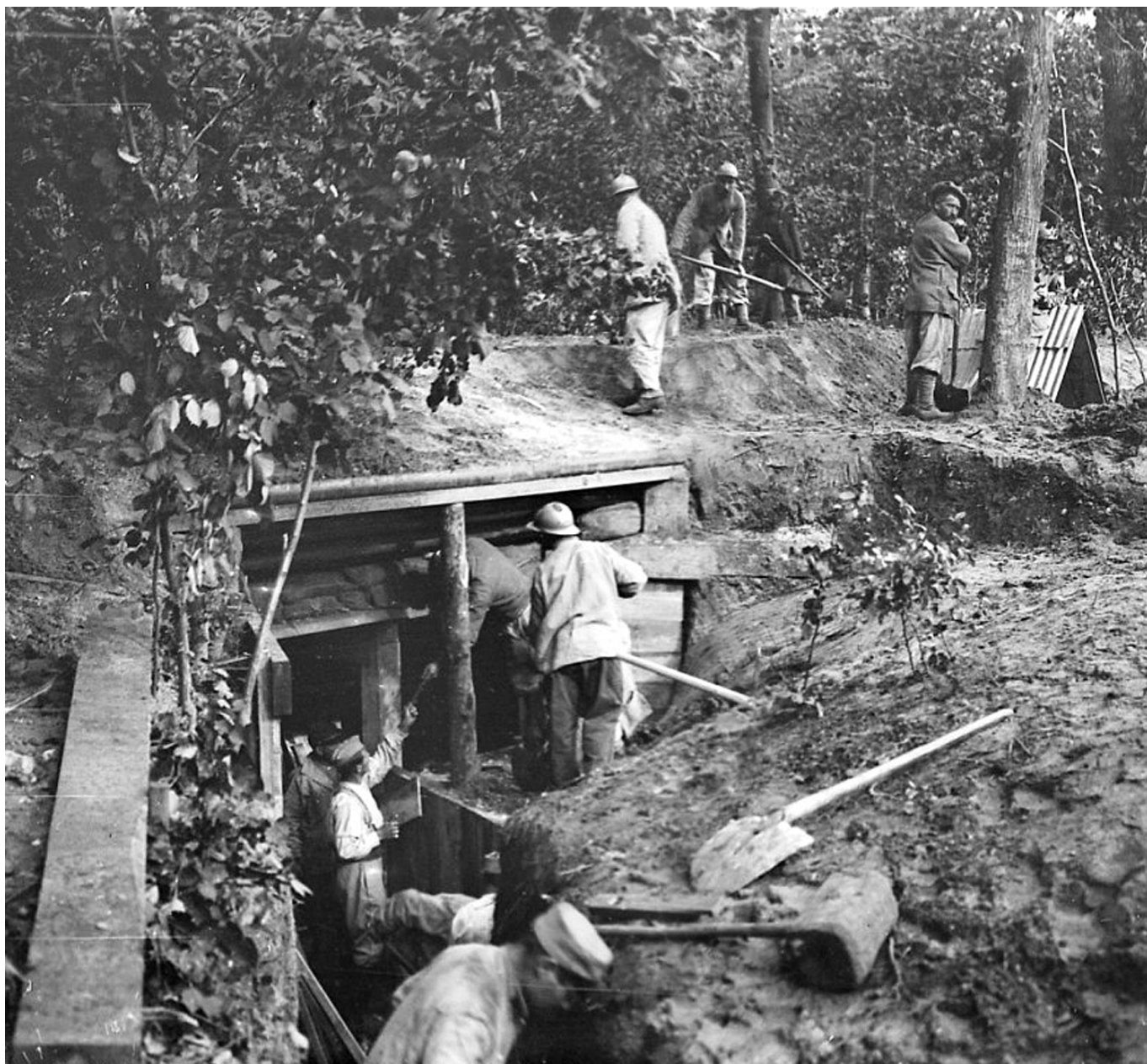
61 Fi 4199, construction d'abris
