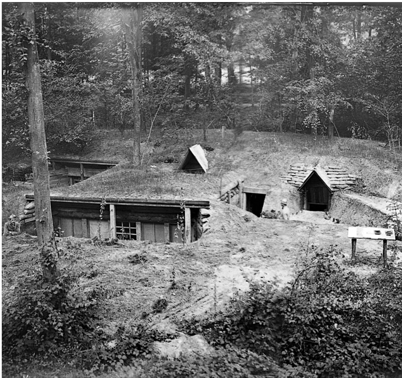
61 Fi 4195, abris enterrés
