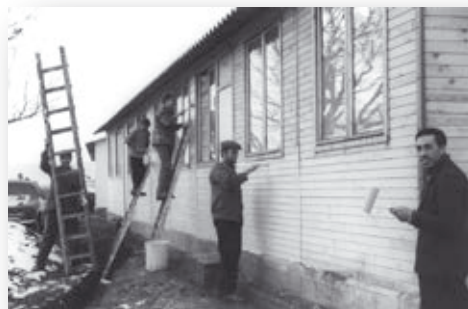
Construction des baraquements
