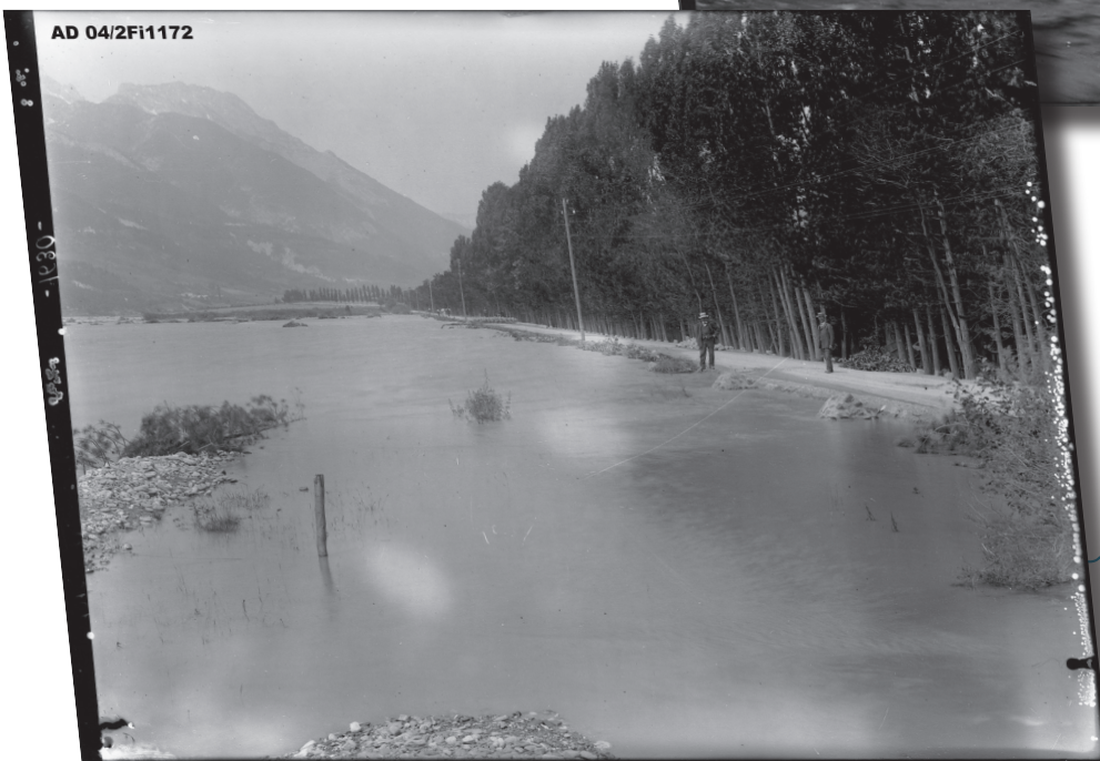
Débordement de l'Ubaye sur la RN 100 15/06/1915. AD04/29 FI 1172
