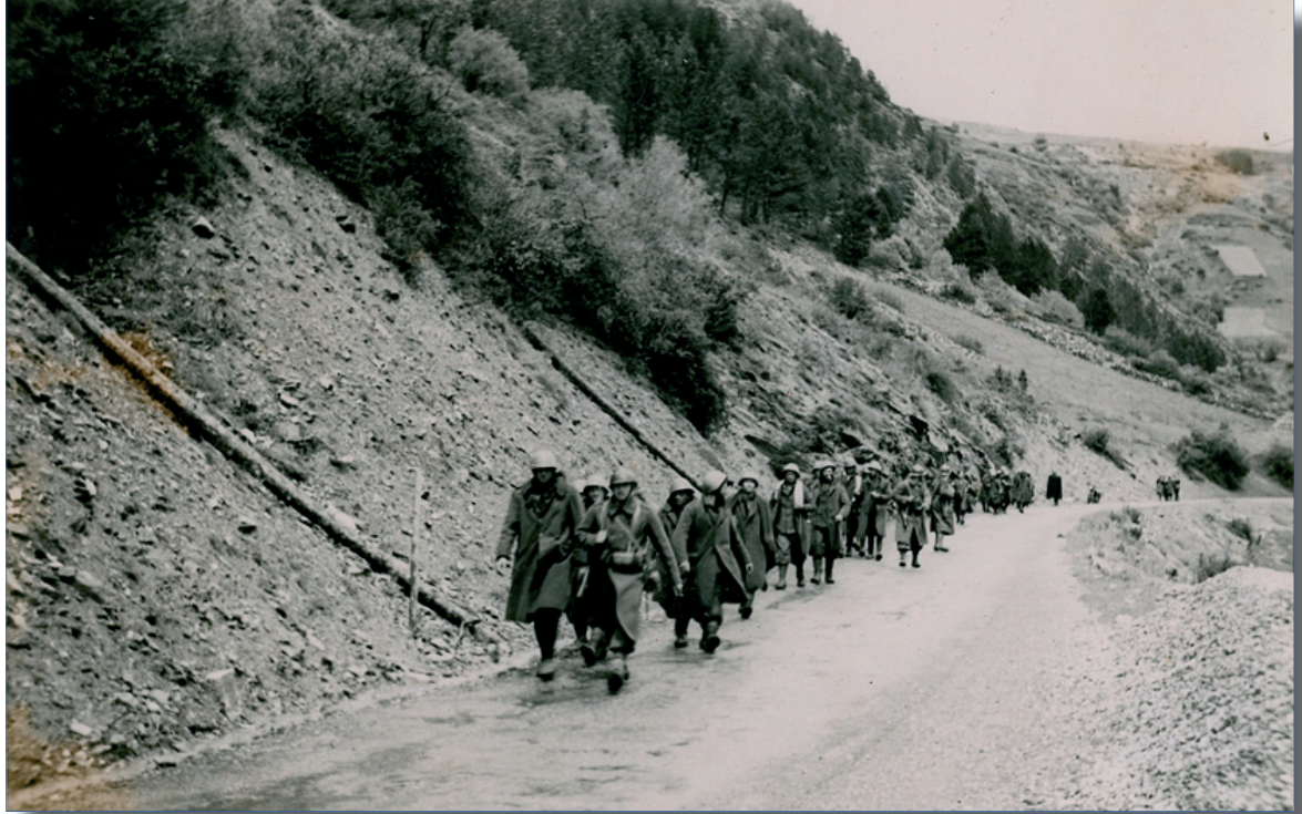
Une colonne de prisonniers italiens escortés par des soldats français - probablement des alpins du 83° BAF - descend la route du col de Larche en dessous du village de Meyrannes, à l'ouest du torrent de Bouchier (ASFD, fonds Grange).
