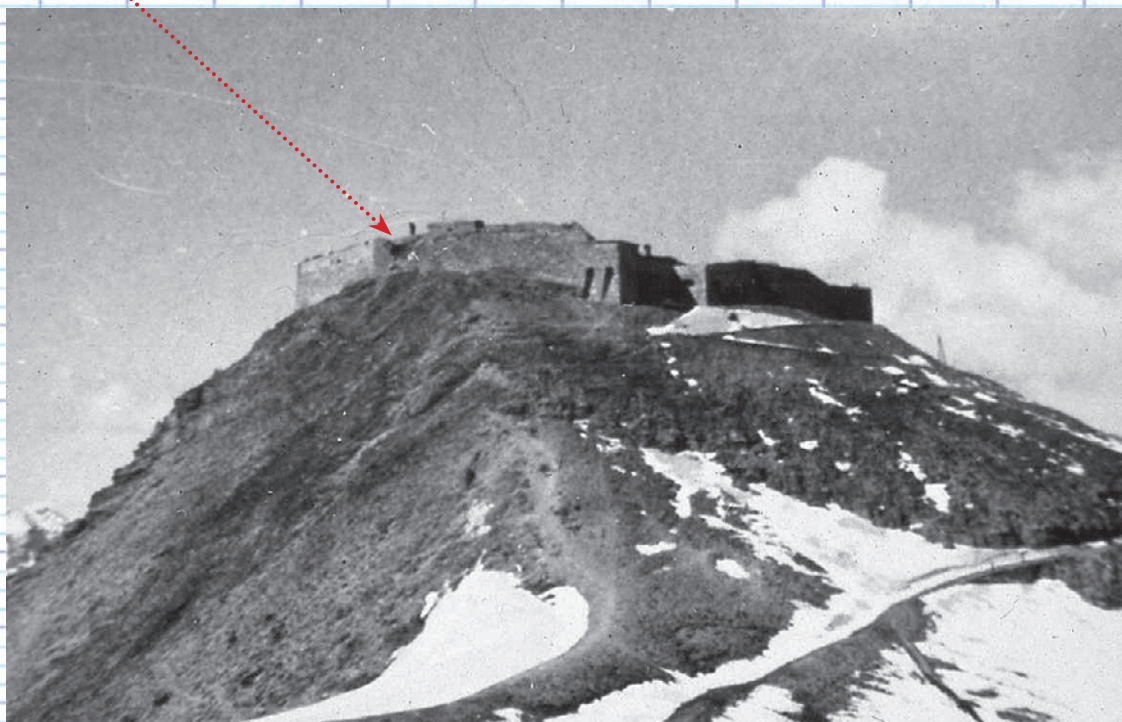
La batterie de Virayse après les bombardements de l'artillerie italienne. Une brèche a été ouverte par un projectile dans le mur d'enceinte (ASFD, fonds Duittoz)..
