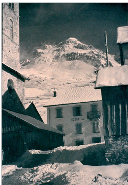
Village de Larche dominé par la batterie de Viraysse, hiver 1939-40 (ASFD, fonds Goens).
