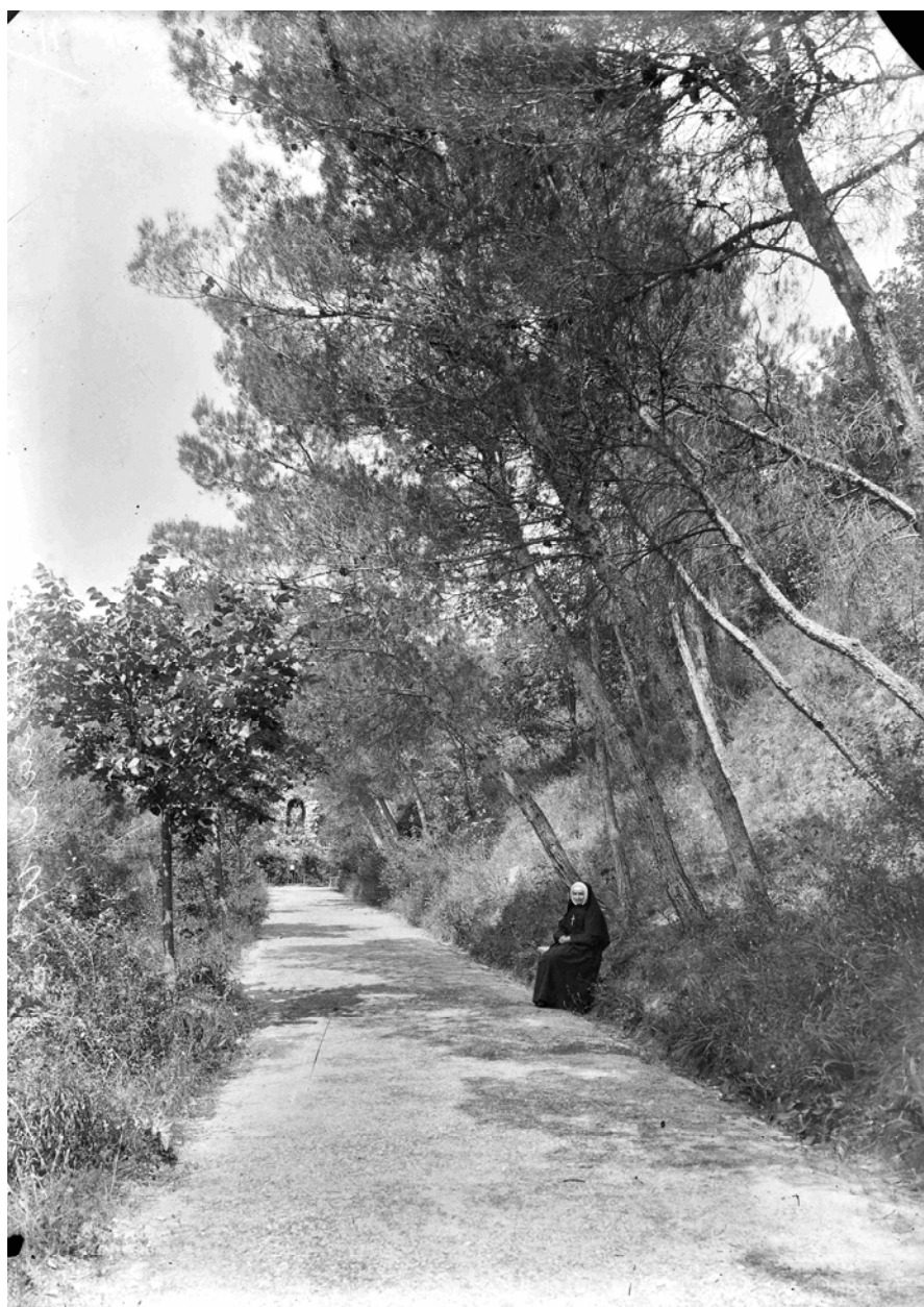
La « grotte de Lourdes » de l'établissement religieux de Saint-Domin à Digne vers 1920
